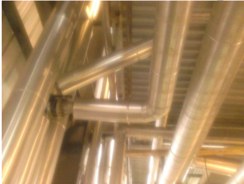
Figure 1 : Avant l'installation de la vanne
