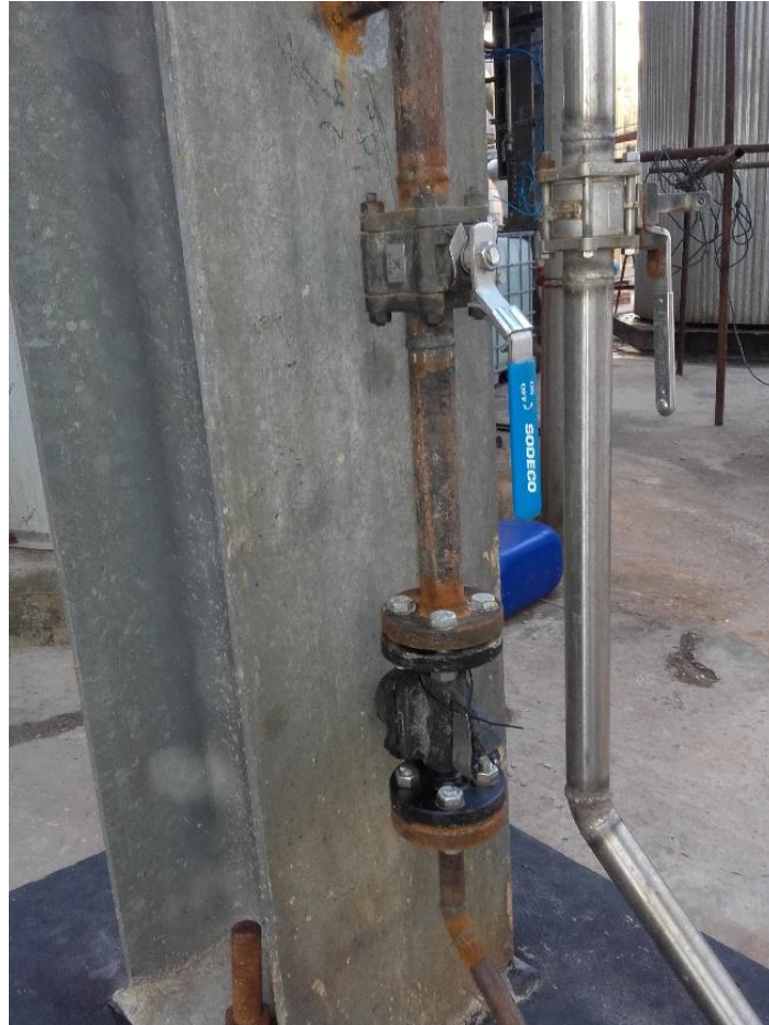
Figure20 : installation purgeur
