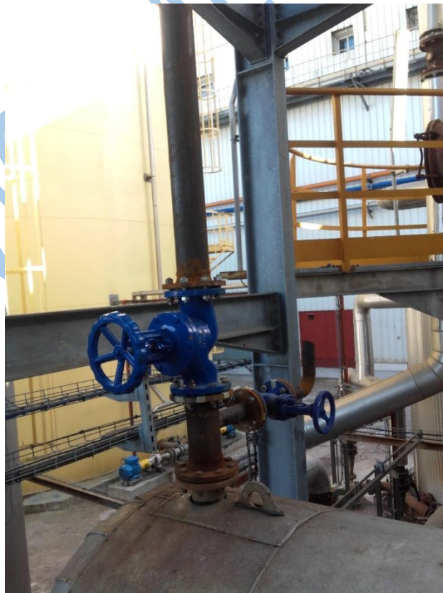
Figure 14 : modification équilibrage bouilleur
