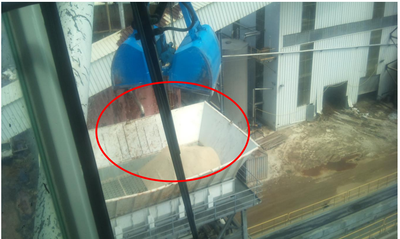
Figure 7 : trémie T011 bouchée en sucre
