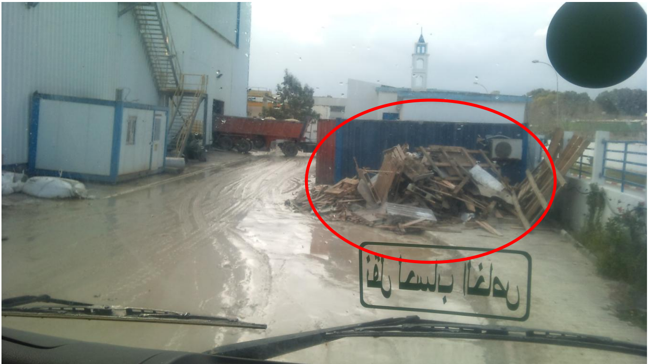
Figure 6 : manque d'accessibilité 'passage camions'
